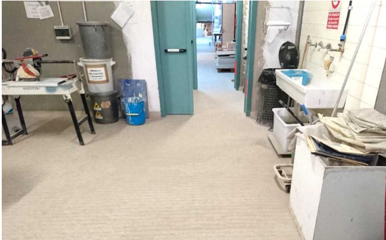
disimpegno ascensore/laboratorio piano interrato
