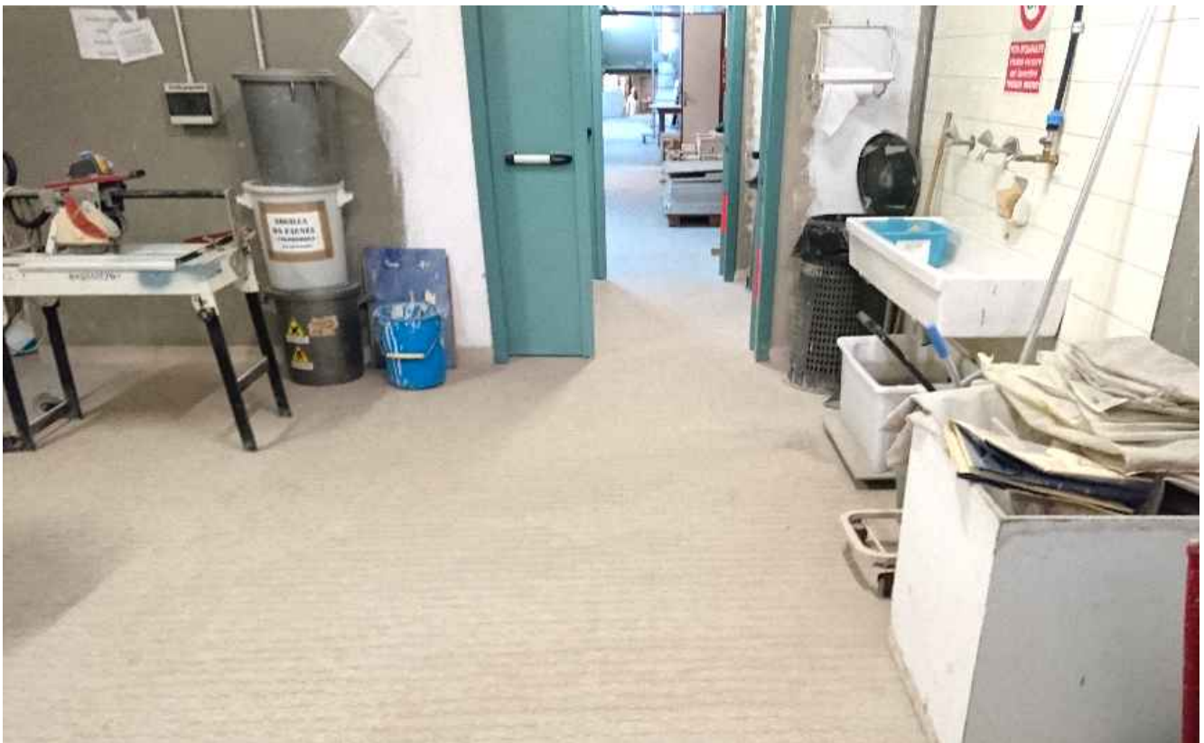
disimpegno ascensore/laboratorio piano interrato
