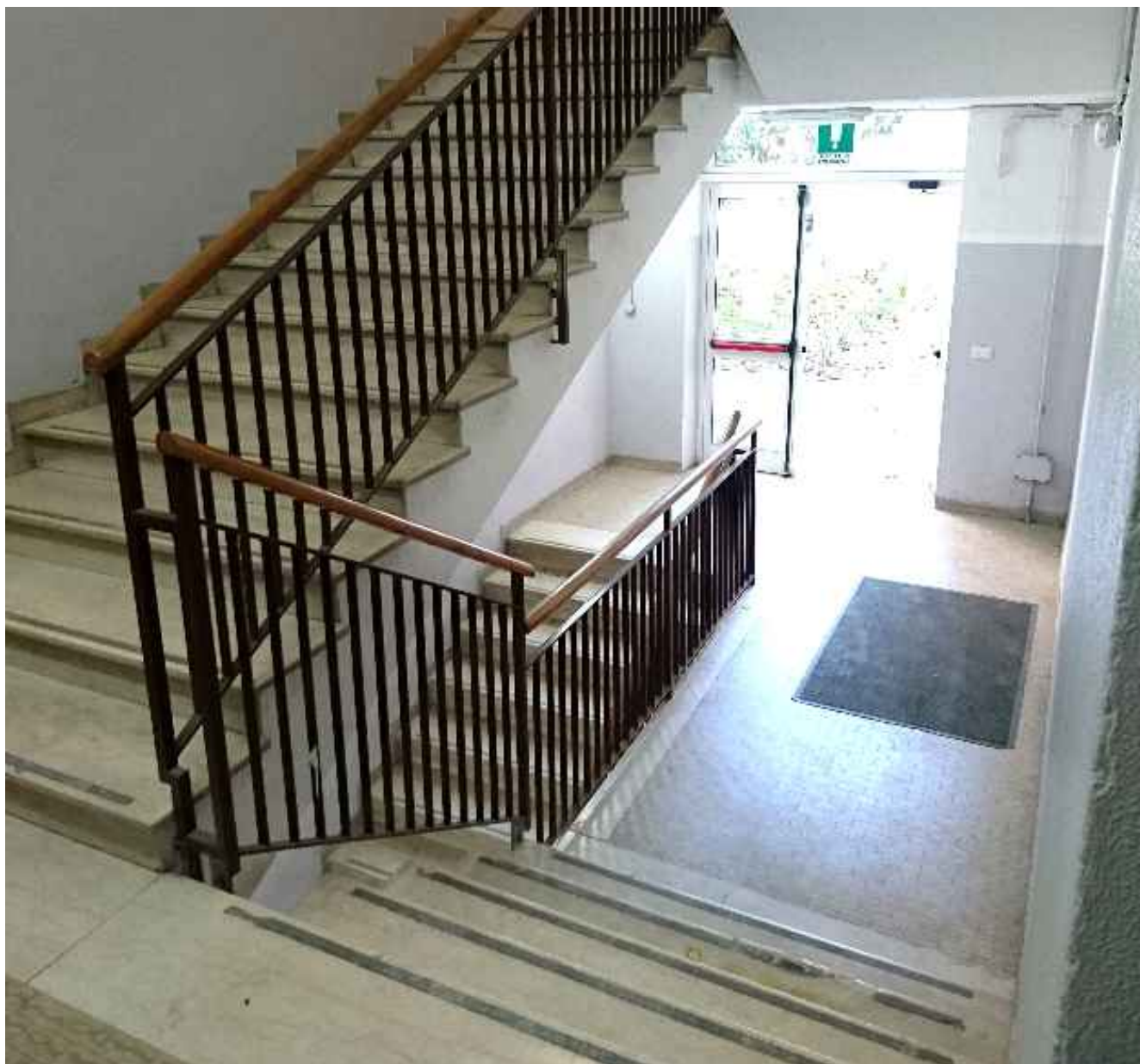
pianerottolo piano terra scala presso corte interna c.so Baccarini
