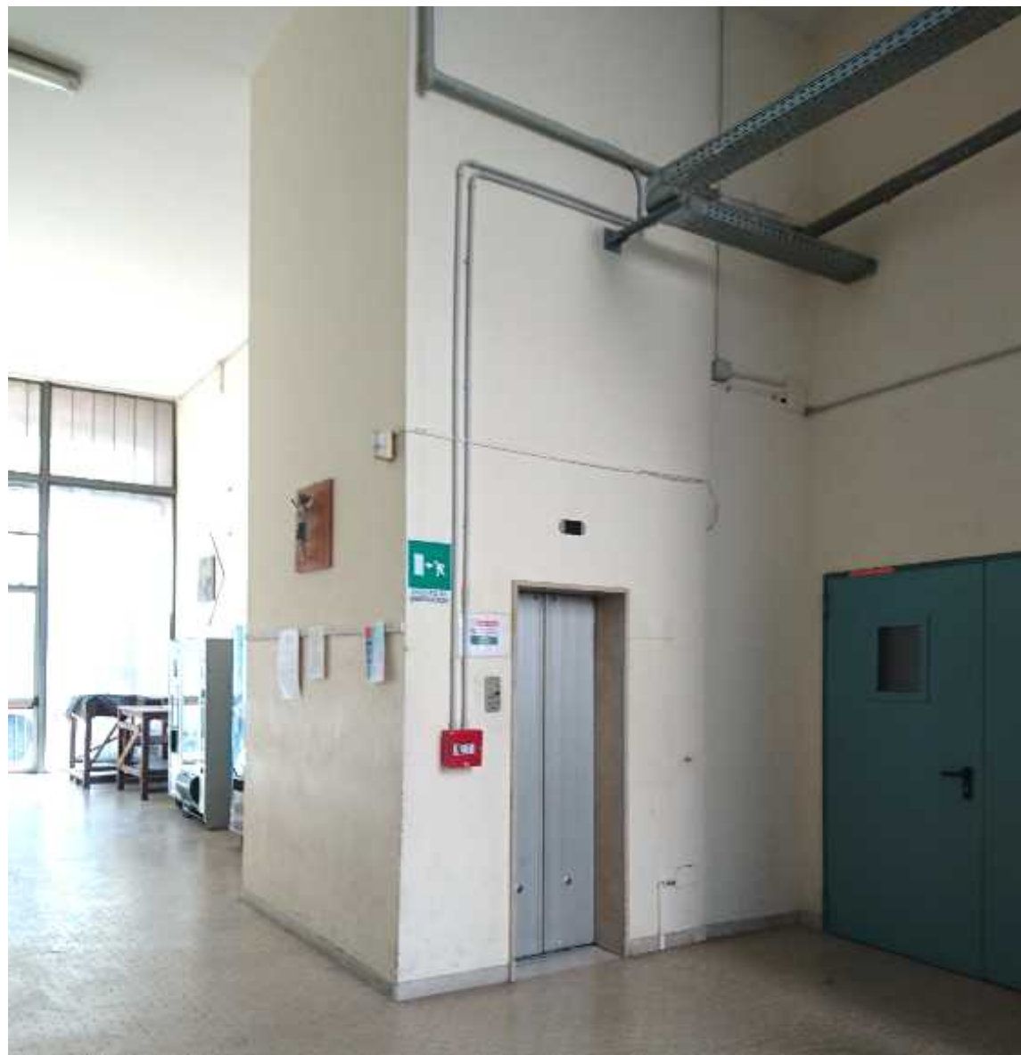
vano ascensore zona bidelleria vicolo S.Nevolone
